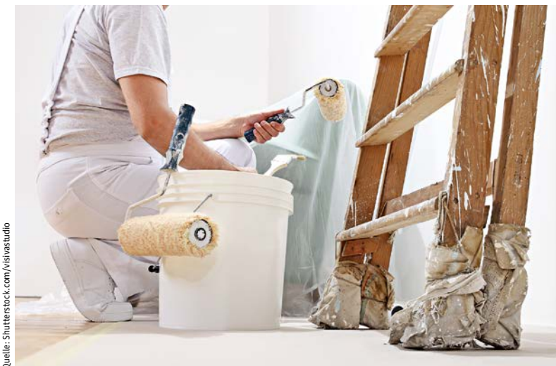
Von Malerarbeiten bis zur Totalsanierung – die im Rahmen eines Mieterwechsels anfallenden Arbeiten können vielfältig sein
